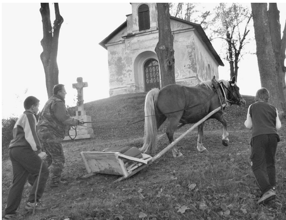
Krytinu na opravu strechy kostola na kalvárii vynášali ťažné kone.
